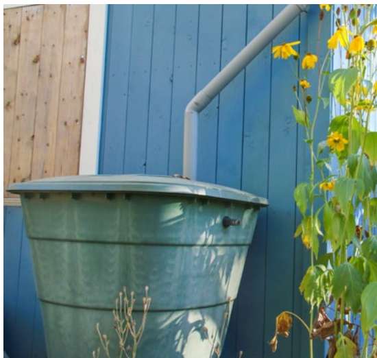
Regenfässer sollten stets mit einem Deckel gesichert sein.
